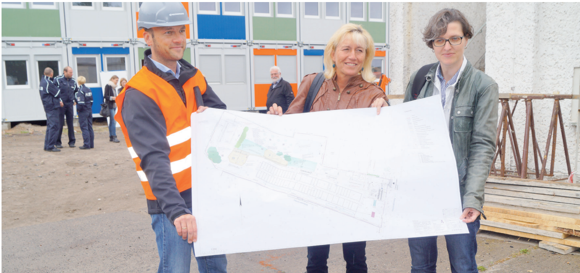
Karin Halsch mit Bezirksbürgermeisterin Birgit Monteiro beim Baustellenbesuch.
